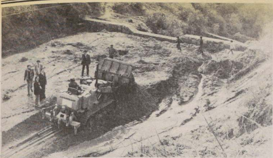
La Municipalidad de Valparaíso, con vehículos pesados, personal de la Dirección de Obras y contratistas particulares, trabaja activamente en el despeje del lodo y arena acumulados en los tranques y cauces de la ciudad. En la foto, el alcalde Francisco Bartolucci inspecciona las faenas en el tranque Betina, del cerro Jiménez.
