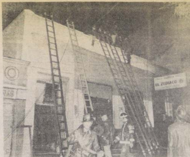
INCENDIO EN FABRICA DE COLCHONES. Un incendio originado por causas que se investigan, redujo a cenizas la fábrica de colchones y espuma "El zodiaco", ubicada en Chacabuco 776, propiedad de Manuel Ruiz Márquez. La acción de las llamas y el agua provocó daños de menor consideración en una bodega de pinturas perteneciente a Leonardo María. En la acción trabajaron nueve compañías de bomberos.
