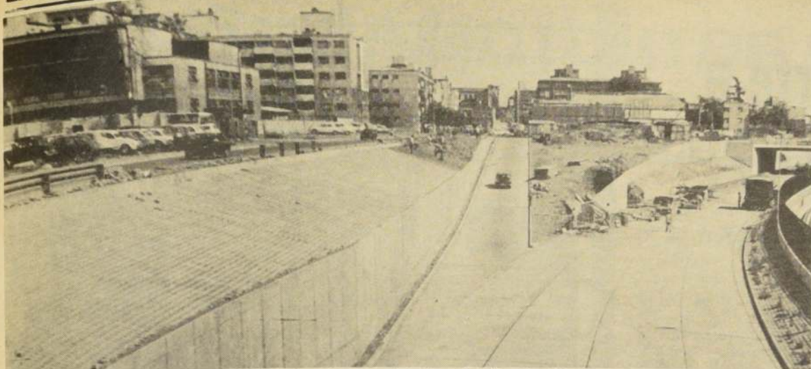
ASPECTOS QUE PRESENTAN las actuales obras de la Avenida Norte-Sur. Cuando esté completa, permitirá cruzar el centro santiaguino en sólo 6 minutos.
