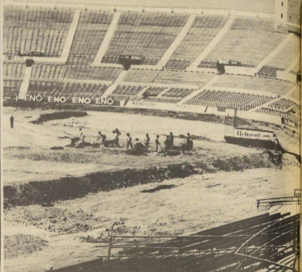
No es el resultado de un bombardeo, sino de los trabajos de remodelación del Estadio Nacional. Nuevo drenaje y césped tendrá el piso del fútbol, y una pista atlética. En la foto, una cuadrilla instala parte del drenaje.
