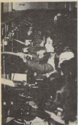
Operadoras de la Compañía de Teléfonos de Chile, en pleno trabajo.
