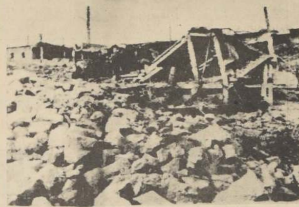
Aspecto de un barrio de una ciudad libanesa bombardeada.
