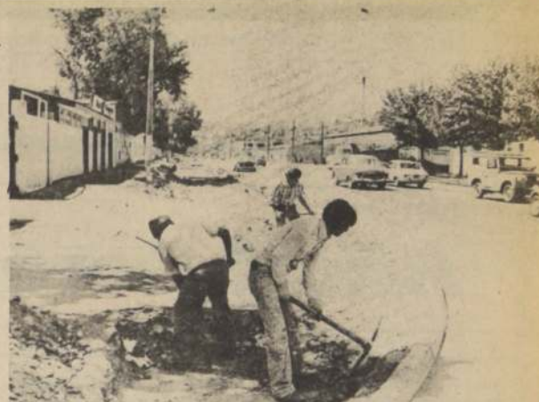
En cinco metros será ensanchada la calle 5 Oriente, entre 1 Norte y 15 Norte en Viña del Mar. La escasa profundidad de los desagües y empalmes de agua obligó al uso de chuzo y pala para efectuar la obra.
