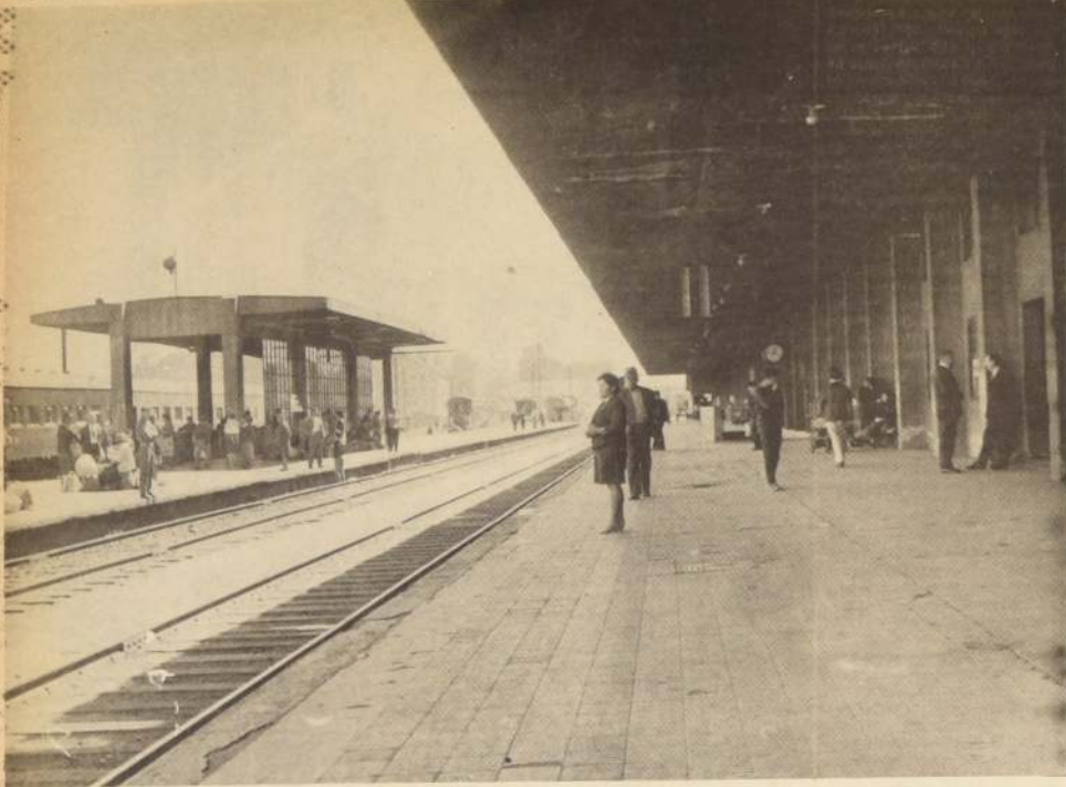
A MEDIADOS DEL PROXIMO AÑO, quedará completada la electrificación de FF. CC. hasta Concepción, lo que permitirá efectuar el viaje a y desde Santiago en sólo cuatro horas. En la foto, un aspecto del recinto ferroviario de Concepción.
