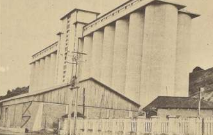
BATERIA DE SILOS EN PUERTO MONTT. Una imponente batería de 24 silos, con capacidad para 5.000 quintales cada uno, ha terminado de construir la ECA en Puerto Montt. Estos silos, que almacenarán principalmente trigo, maíz y avena, forman parte de un complejo de instalaciones de este tipo construidas, en parte, con aportes otorgados, dentro del programa de la Alianza para el Progreso, por Estados Unidos, en Santiago, Curico, Corte Alto y Los Lagos.
