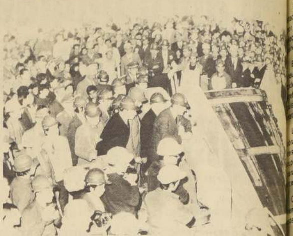
EN CALETONES , el Presidente observa una colada de cobre, junto al carroussel. Un pan de cobre ha caído al agua y muy pronto, después de enfriarse, tomado en carretilla y embarcado a Rancagua.
