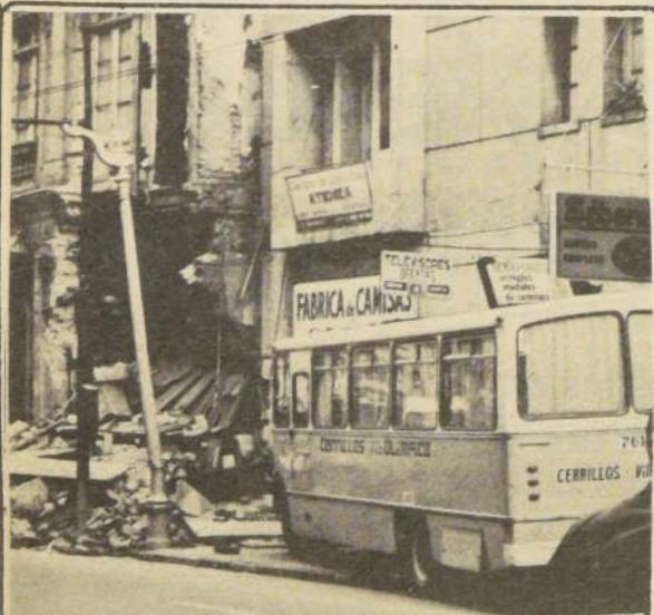
MICRO DERRIBOUNA CASA. — Reducido a escombros quedó el inmueble de dos pisos de calle Merced 580, en esta capital, luego que el microbús recorrido Cerrillos - Villa Olímpica, placa JCN- 617, de La Cisterna se incrustara en su frontis debido a un corte en el sistema de dirección. En ese lugar funcionaba una industria de calzado que anteriormente ya había sido afectada por un hecho de esa naturaleza. Carabineros informó que el conductor del vehículo sufrió lesiones menores y que fue detenido por su responsabilidad en el accidente. Los pasajeros escaparon ilesos. En la fotografía se puede apreciar la magnitud del suceso.
