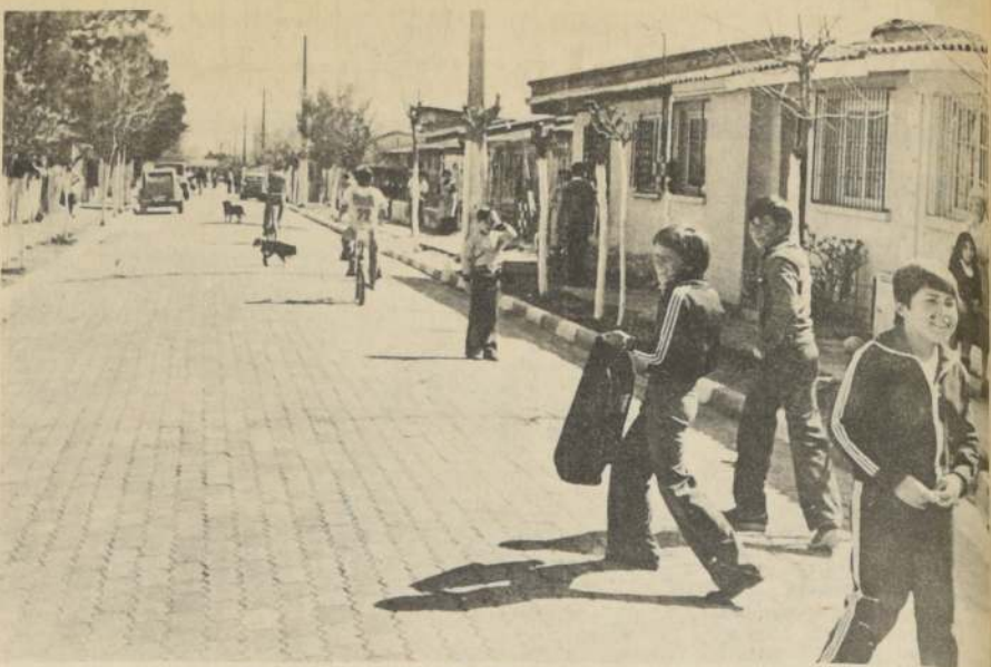
Alrededor de 50 mil metros cuadrados de asfalto y adoquín cubren las obras de pavimentación realizadas en la Población José María Caro, de La Cisterna, con un costo de 6 millones de pesos, inauguradas ayer.
