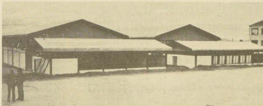
TOTALMENTE TERMINADOS SE ENCUENTRAN LOS NUEVOS PABELLONES para talleres y salas de clases del Instituto Politécnico de Cauquenes. La Dirección de Arquitectura invirtió una suma aproximada a los 4 millones de pesos.
